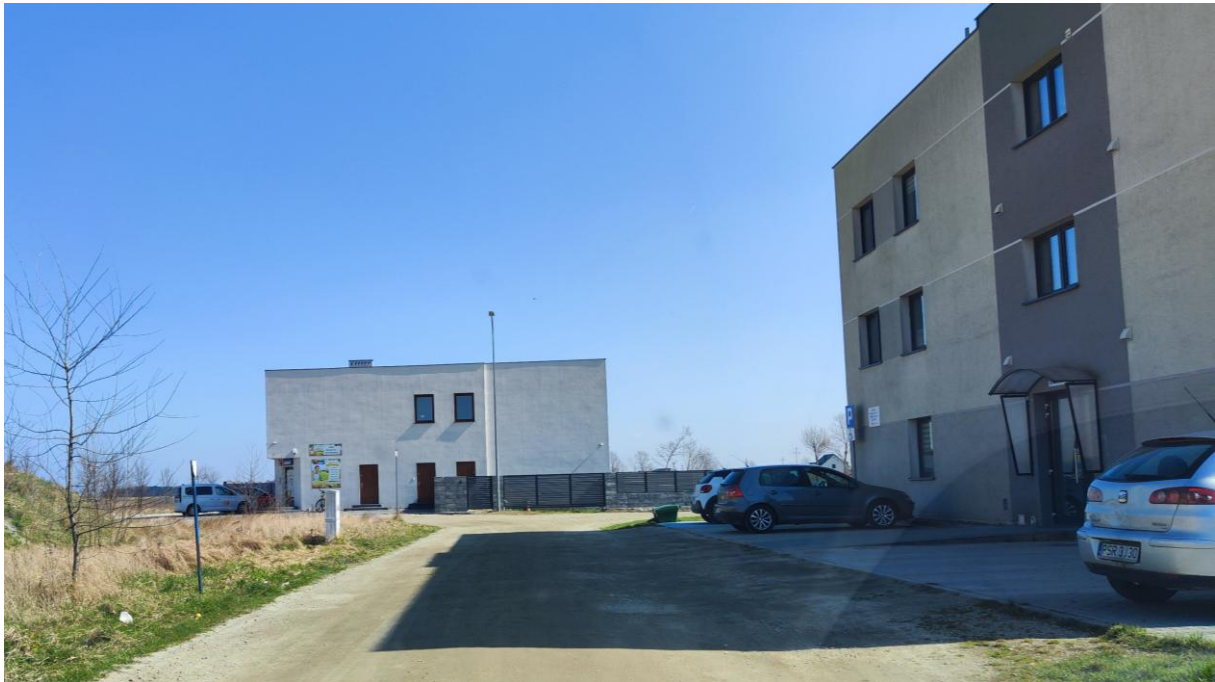
Ryc. 7. Widok na sąsiedztwo
